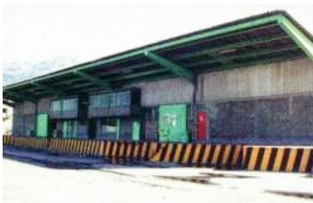
Si la iluminación natural es insuficiente, pueden colocarse paneles de vidrio o plástico en el techo. Generalmente no es necesario una instalación eléctrica contra incendio, salvo en el caso de gran cantidad de inflamables o aerosoles. No obstante, siempre es recomendable instalar los interruptores en la parte exterior del depósito.
